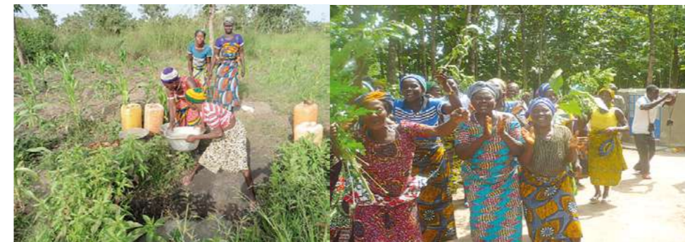
La joie des femmes devant la pompe juste installée !! Avant, elles allaient chercher l'eau au marigot... à 12 km ... et ramenaient 2 bidons de 25 litres sur leurs vélos .... sur des pistes sableuses !!!
